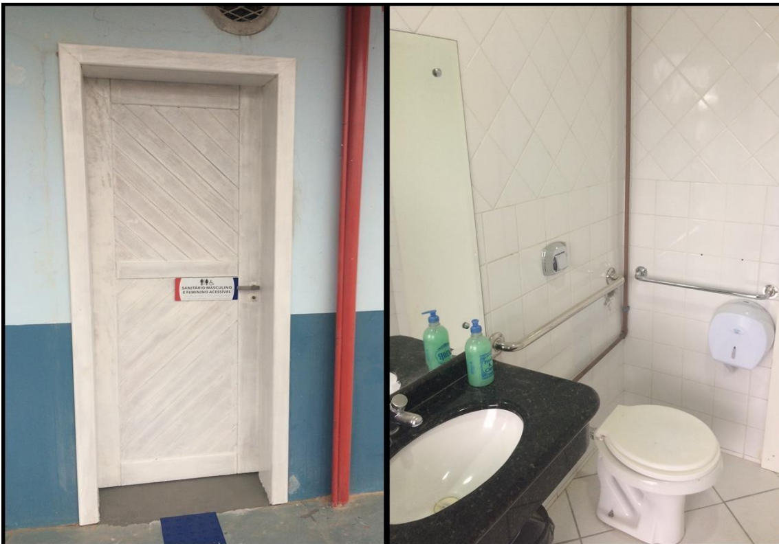
Figura 84: Vista do banheiro específicos para PNE's no piso térreo
